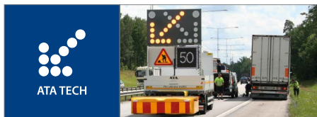
TMA-skydd, ljuspilsutrustningar, VMS och ITS
