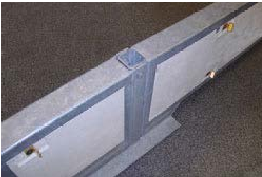
fig. 3 Skarv mellan två 6-meterssektioner
